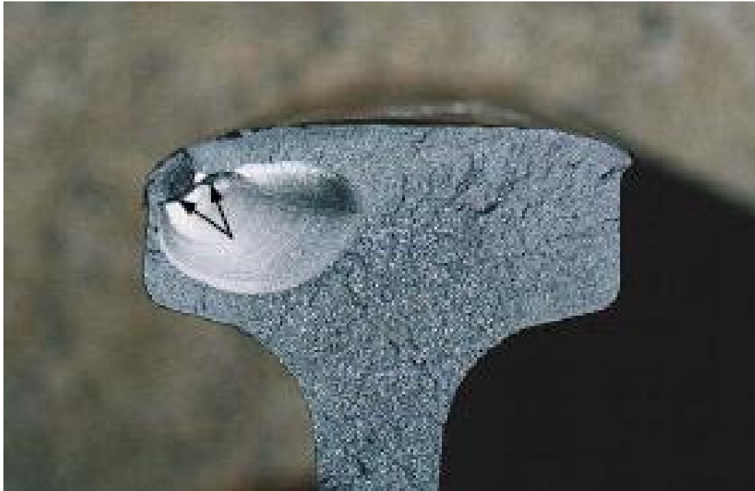
Fig. 3.6 - Defeito transversal causado por shelling Fonte: Marich 2005
