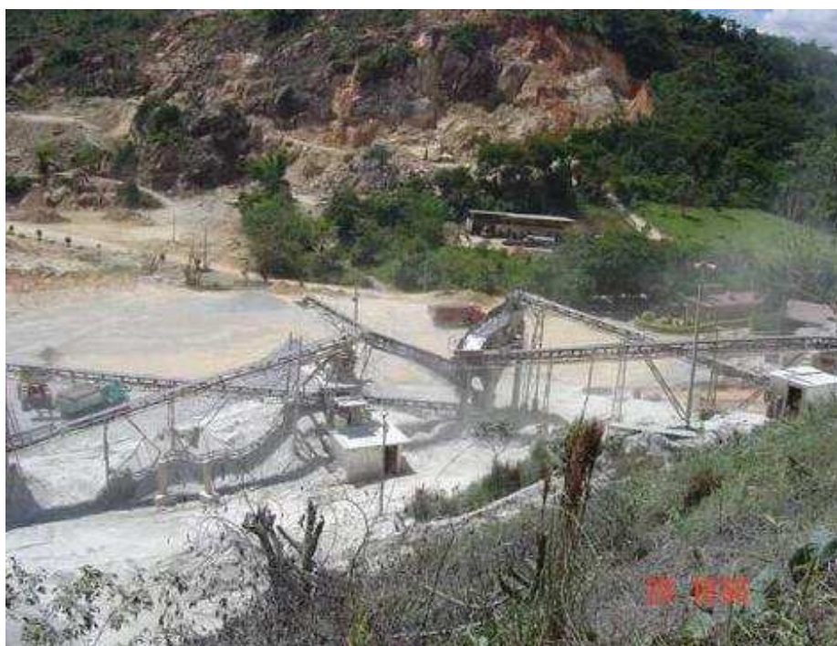
Figura 7: Vista dos pulmões de brita para lastro
