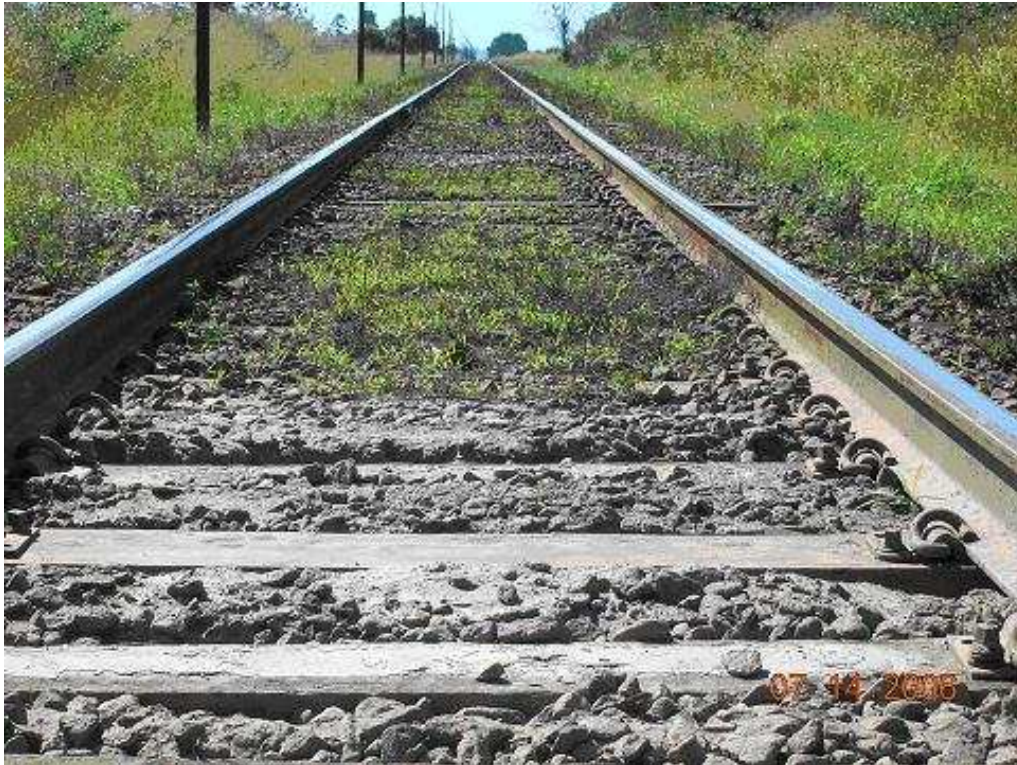
Figura 2: Presença de vegetação no lastro
