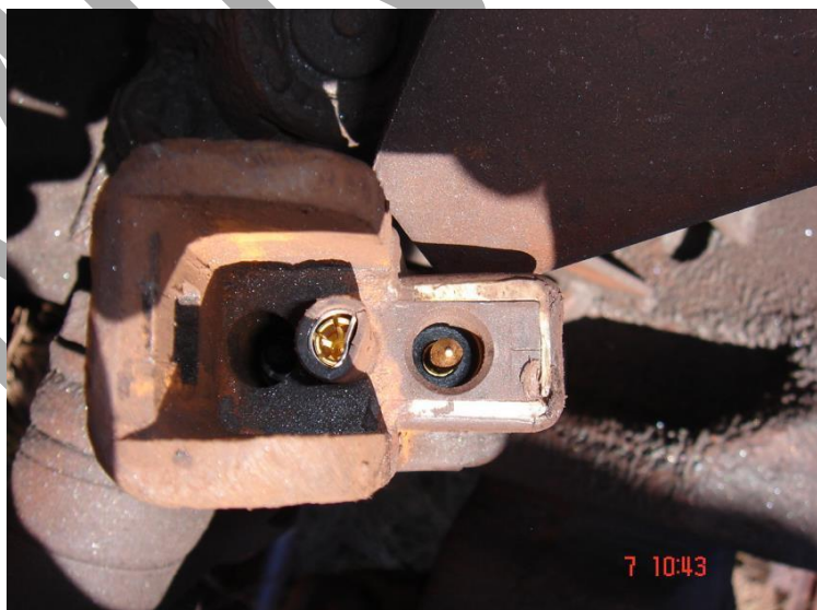
Figura 3 – Conectores com pino danificado
