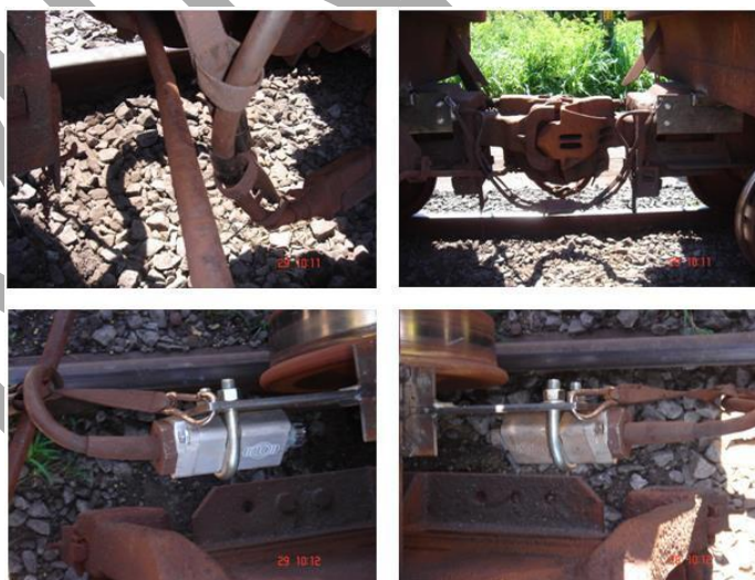
Figura 20 – Nova posição dos cabos no lado oposto do engate, e novas EOC-JB 's
