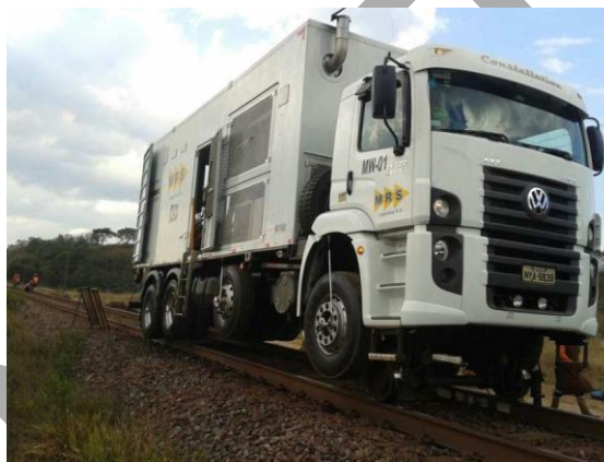
Figura 9: Caminhão utilizado para realização de solda flash butt
