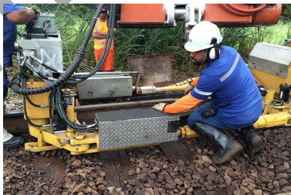
Figura 10: Processo de alinhamento e nivelamento dos tops dos trilhos
