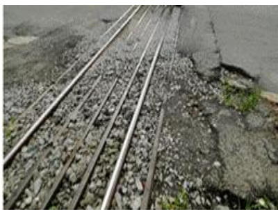
Figura 02: PN com Pavimento de trilhos e brita
